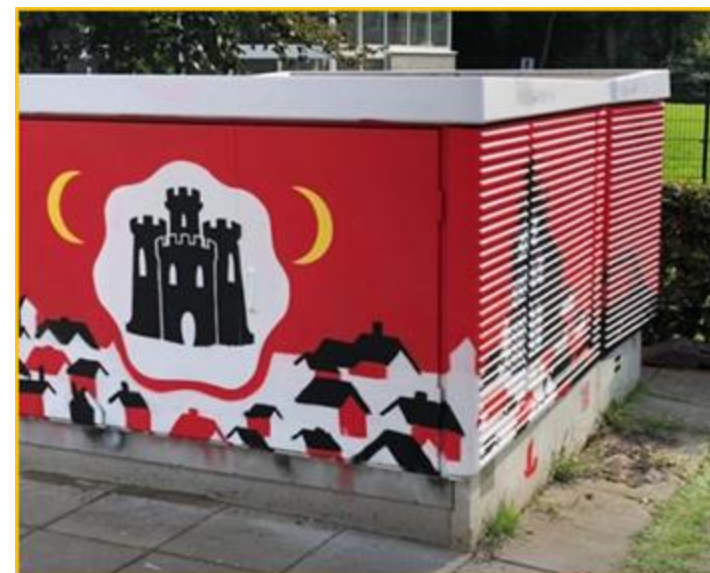
Een transformatorhuisje in de buurt
