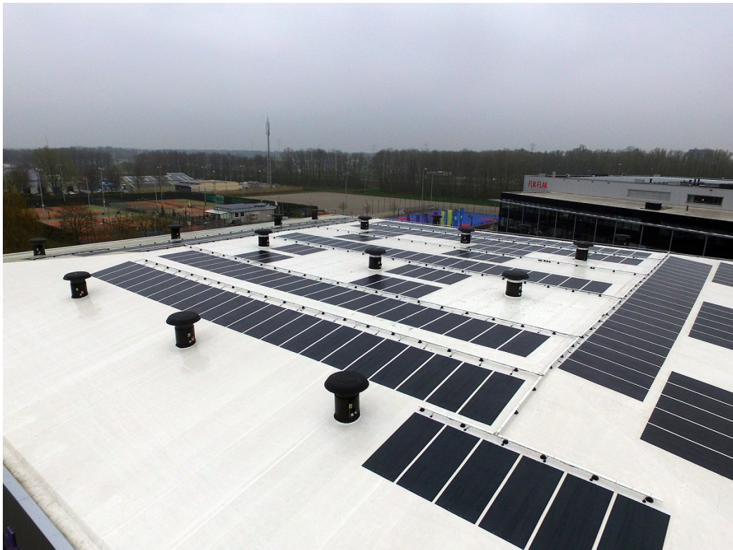
Lichtgewicht zonnepanelen op de Maaspoorthal in Den Bosch – bron: Stiels B.V.
