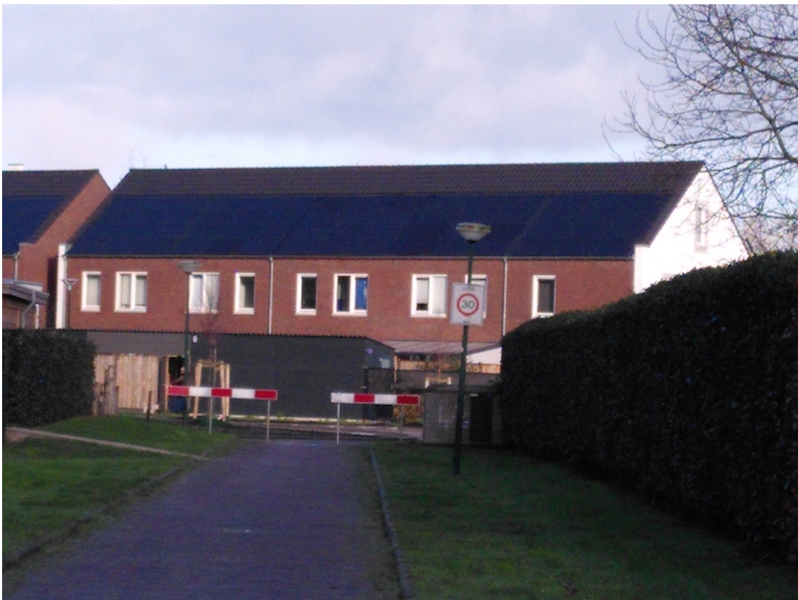
Nieuwbouwwoning met dak dat niet volledig is bedekt met pv – bron: Anne-Marie Spierings
